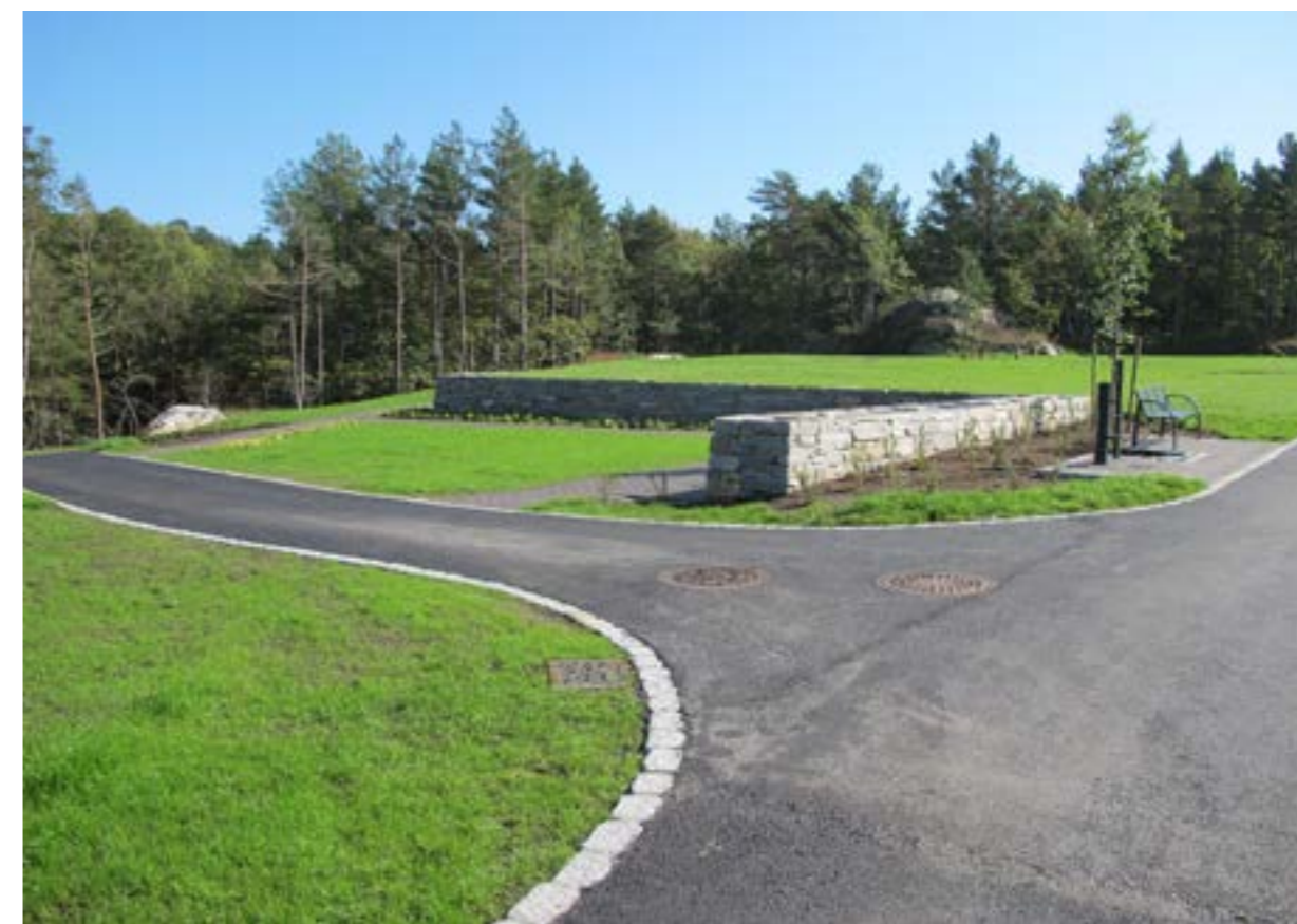
Eksempel på tilføyelse til kapittel 3 - kode 3.6, Kantstein uten vis mot veikropp for overflateavrenning til drenerbar masse.
