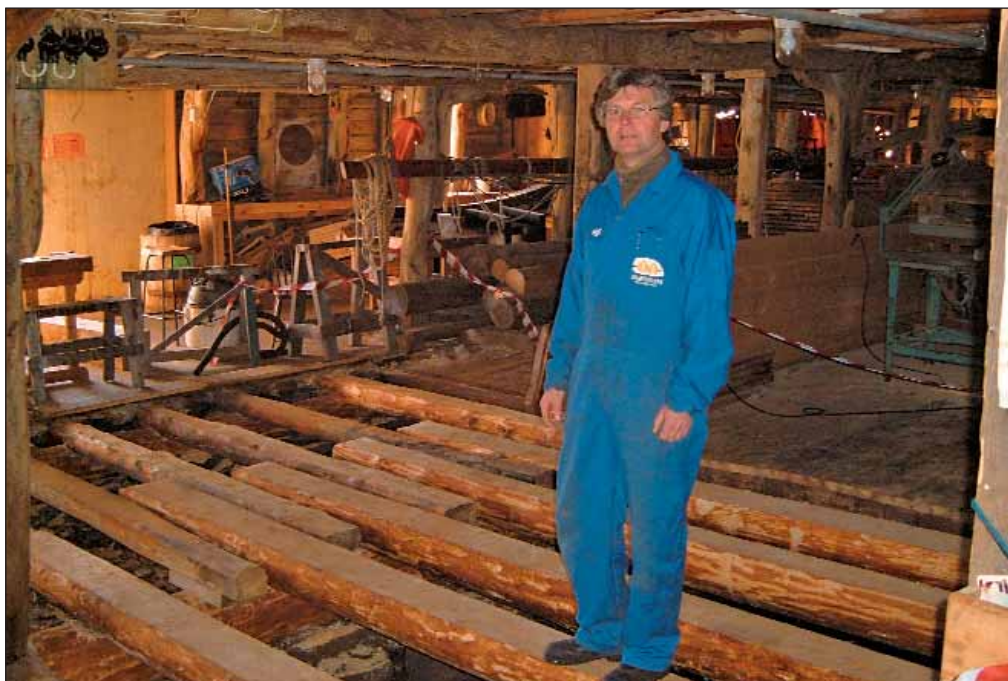
Daglig leder Ketil Thu inspiserer de gjenstående restaureringsarbeider.
