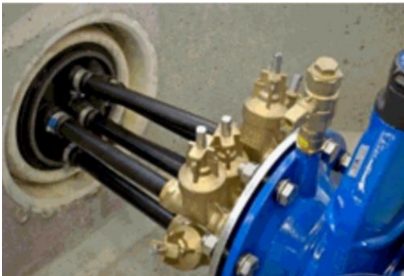
Figur 9. Eksempel på stikkledninger som ligger buntet sammen
