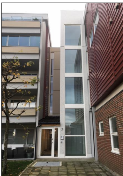
Fasaden av påbygg med heisrom til en av oppgangene i Kvitodden borettslag på Hundvåg i Stavanger.
