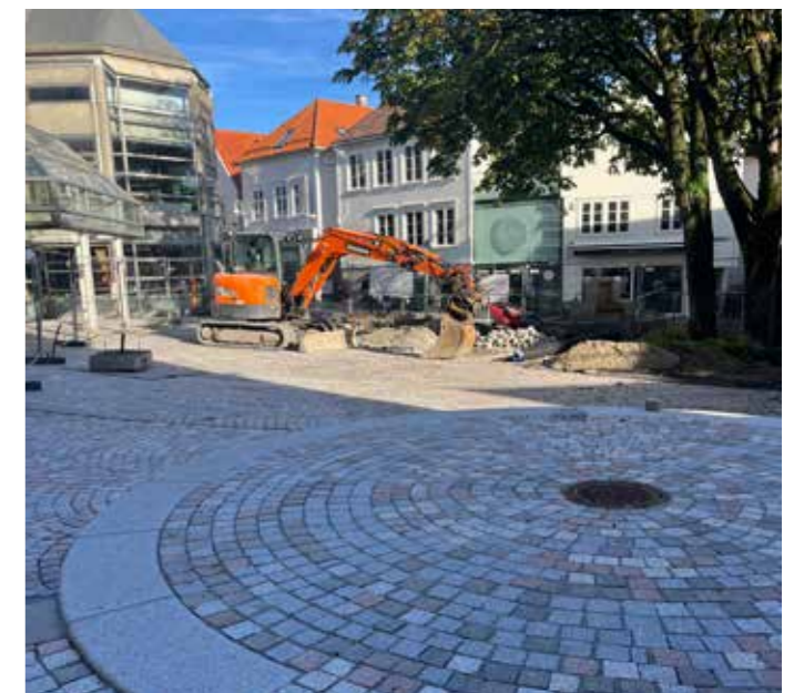
Figur 2. Ny scene på Arneageren, fra byggeplass 2024.
