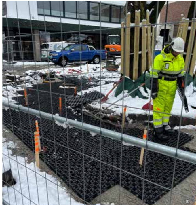
Figur 28. Foto, legging av sandwichpanel, Arneagaren 2024
