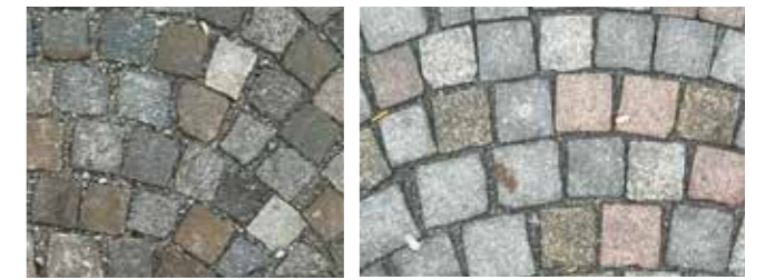
Figur 17. Smågatestein i buemønster med brukt/slipt stein
